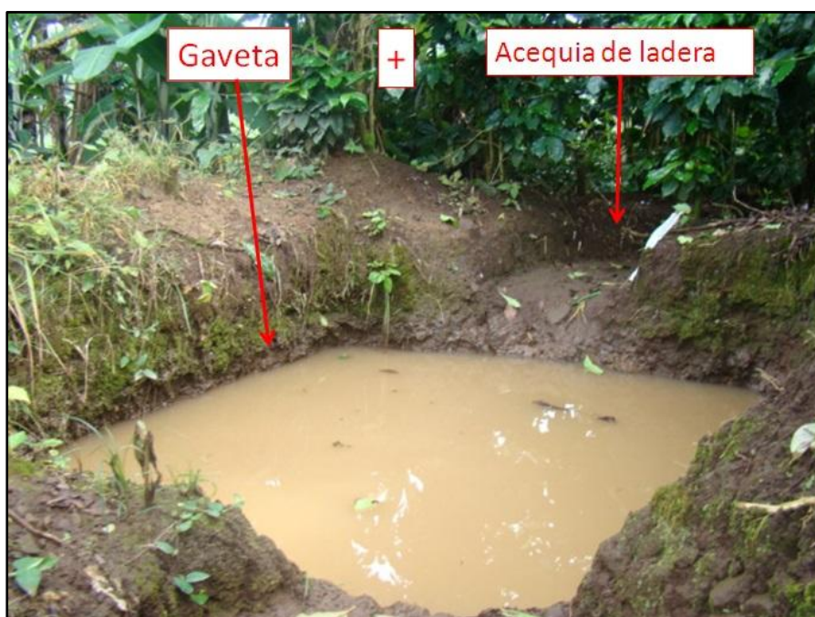
Figura 28. Fotografía de una acequia de ladera y una gaveta de recolección en el área de muestreo CSS-30+AG (finca Parte Media) con aproximadamente 1,5 m de profundidad, tomada en setiembre del 2013.
