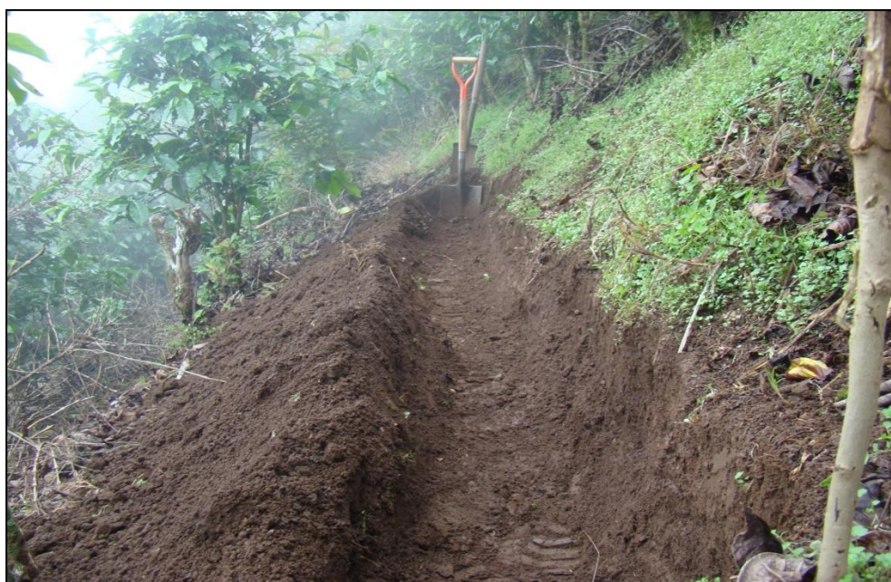
Figura 12. Fotografía de la fosa de excavación para la colocación del geotextil de recolección correspondiente a una microparcela de erosión de 21 m 2 en un área de muestreo de CSS-60+AG.
