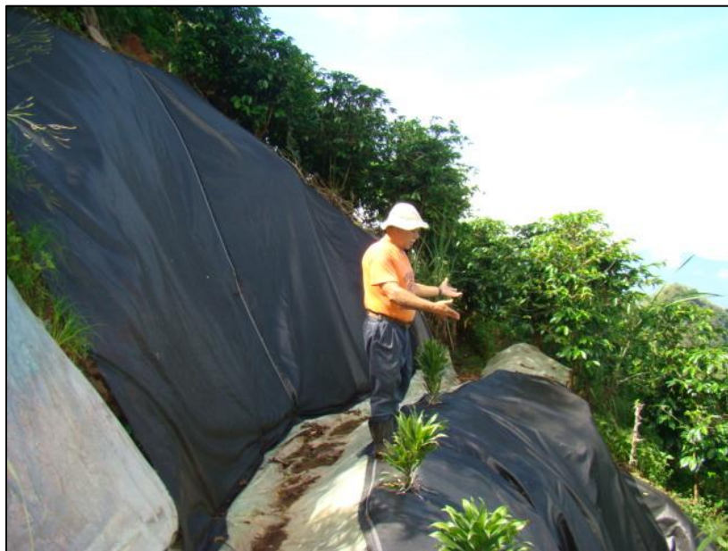
Figura 38. Fotografía de los taludes de la acequia de ladera en la cárcava Costado Sur, ubicada en la finca Parte Media, cubiertos por plástico y geotextil T2100 y sembrados con caña india ( Dracaena spp.).
