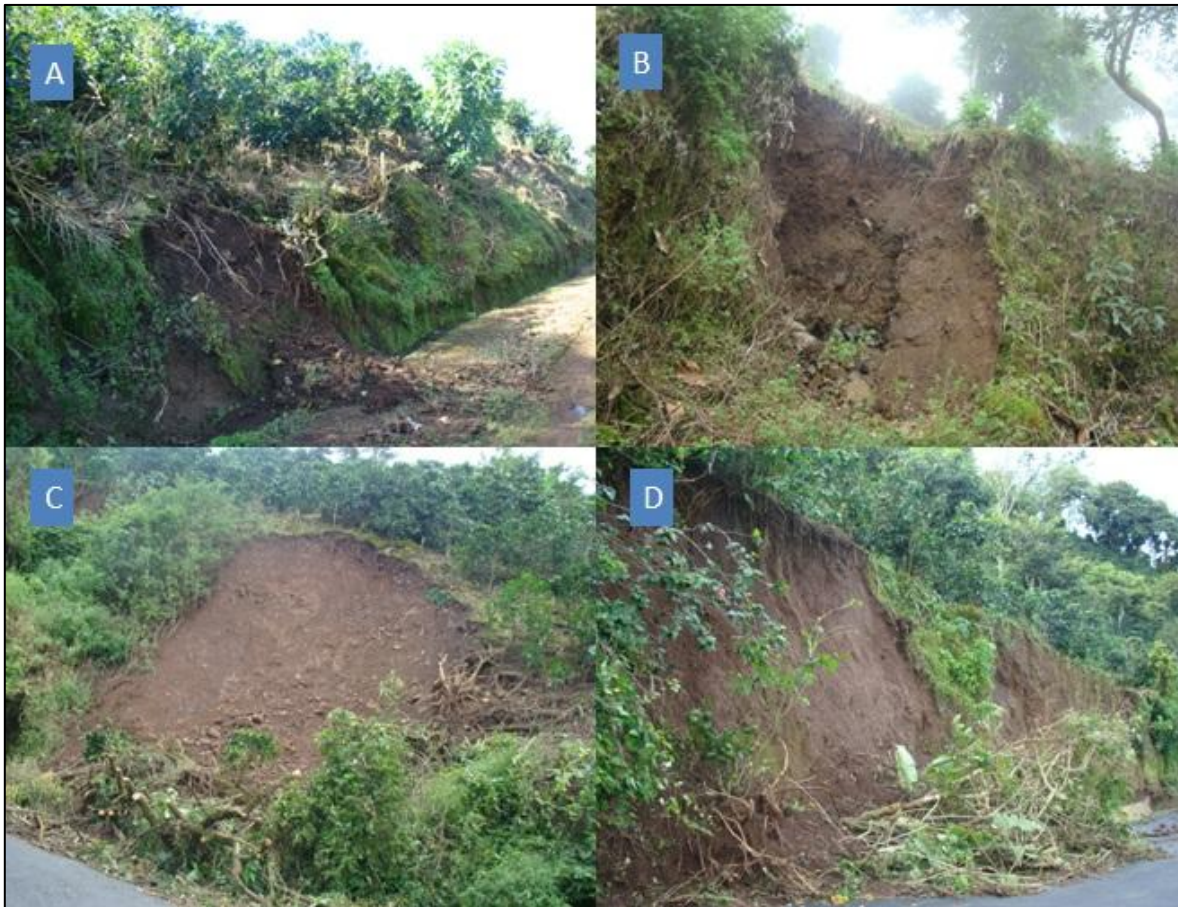
Figura 33. Fotografías de microdeslizamientos en distintas partes del área en estudio. A: Dentro de los caminos de la finca Parte Media, B: Dentro de la finca Parte Alta, C y D: Al borde de la carretera de la finca Parte Alta.
